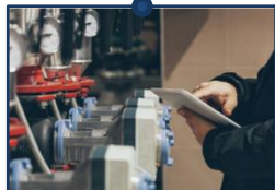
Модернизация инженерной инфраструктуры 10,5 млрд. ₽
